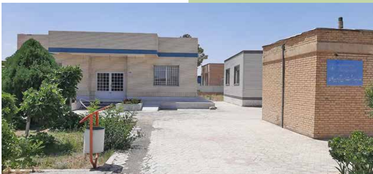
احداث خانه بهداشت حسن آباد تنگ بیدکان با کمک خیران سلامت شهرستان مبارکه
